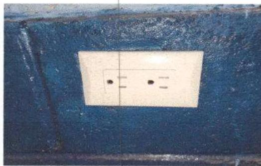
Foto 4: Sustitución de tomacorrientes dobles en módulos 1,2,3,4,5,6 y 7
