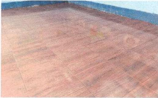
Foto 3: Sustrucción de piso de cemento líquido por cerámico, módulo 2
