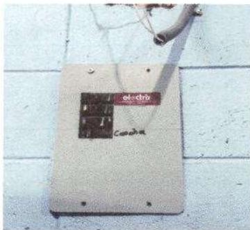
Foto 5: Sustitución de flipones, en Dirección del establecimiento.
